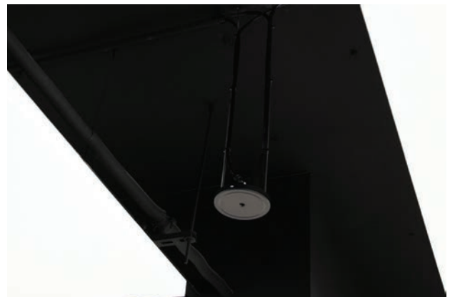
▲ De HumiLife bevochtigingsunit is vrijwel onzichtbaar in het plafond geïntegreerd.
